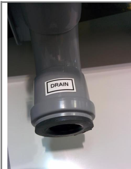
El drenaje de condensado se encuentra en la parte posterior de la cámara de ensayos Alpha.
