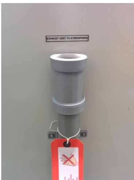
Escape: tubería de 40 mm de diámetro.
